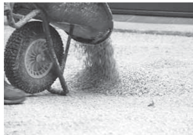
Aanbrengen van de vul en deklaag
